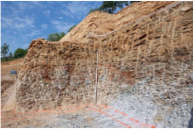
Abb. 26: Umiken-Chilhalden 2022 (Umi.022.1). Blick von Südosten auf den unteren Baugrubenbereich. Die 4 m hohe, mit dem Baggermeissel abgespitzte Profilwand zeigt die geologische Schichtabfolge mit hellbraunem Schwemmlerhm, grünlichem Molassesandstein und Nagelfluh. Links oben markiert der Waldrand den Verlauf der historischen Bözbergstrasse.
