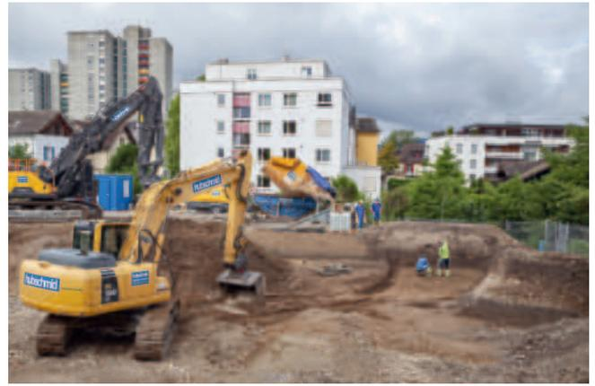
Abb. 27: Brugg-Wildenrainweg 2022 (Bru.022.3). Arbeitsfoto von Osten zur westlichen Baugrubenwand. Über dem anstehenden gelben Silt liegt eine neuzeitliche Humusschicht, gefolgt von einer bis zu 2 m starken modernen Aufschiebung.
