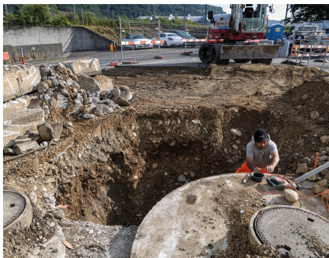
Abb. 14: Windisch-Zürcherstrasse 2024 (V.024.5). Arbeitsfoto von Südwesten auf die laufenden Aushubarbeiten. Unter modernen Planien ist überall der anstehende glaziale Schotter angeschnitten. Im Hintergrund der Bahndamm der SBB-Linie Brugg-Baden.
