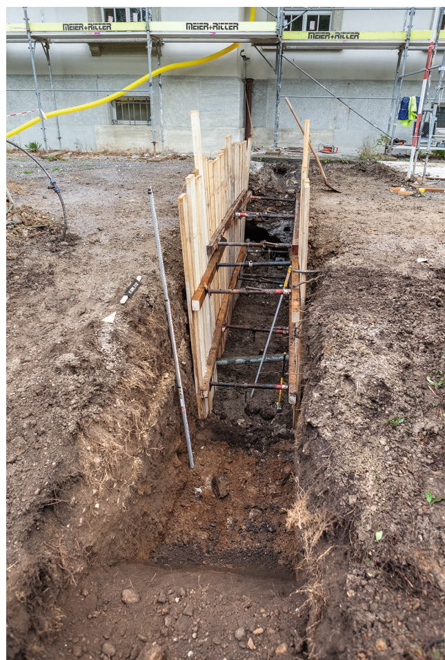
Abb. 15: Windisch-Königsfelden (Hauptgebäude) 2024 (V.024.7). Ansicht von Südosten in den Werkleitungsgraben vor der Südwestfront des alten Klinikhauptbaus. Im vorderen, noch nicht verspriesteten Westprofil ist knapp 1,2 m unter aktuellem Terrain der Rest eines Gartenmauerfundaments als helle Planierungsschicht erkennbar.
