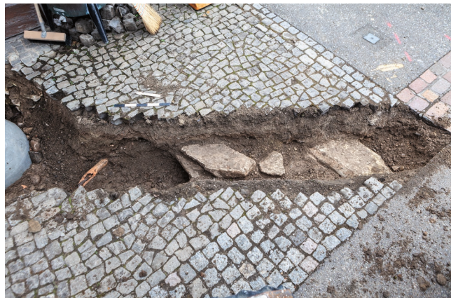
Abb. 31: Windisch-Lindhofstrasse 2024 (V.024.1). Blick von Westen auf den Werkleitungsgraben unmittelbar westlich des alten Feuerwehrmagazins mit gesetzten Steinplatten und Tonröhrenleitung (links).
