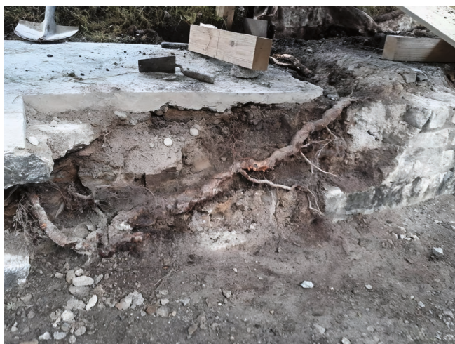
Abb. 3: Windisch-Amphitheater (V.024.80). Der freigelegte Wurzeleinwuchs hinter der äusseren heute aufgehenden Mauerschale und direkt unter der Mörtelabdeckung des beschädigten Abschnitts von Mauer 20.
