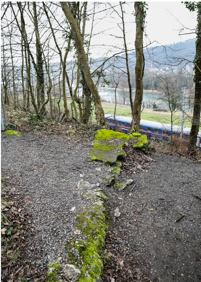
Abb. 8: Monitoring Ruinenstätten 2024 (V.2024.202). Heutige Aufnahme des nordwestlichen Endes des Mauerabschnitts von 1897 an der Abbruchkante zur Aareniederung. Deutlich zeigt sich der Verlust grosser Teile der Mörtelabdeckung und der teilweise erfolgte Verlust der 1903 konservierten feindseitig orientierten Mauerschale.
